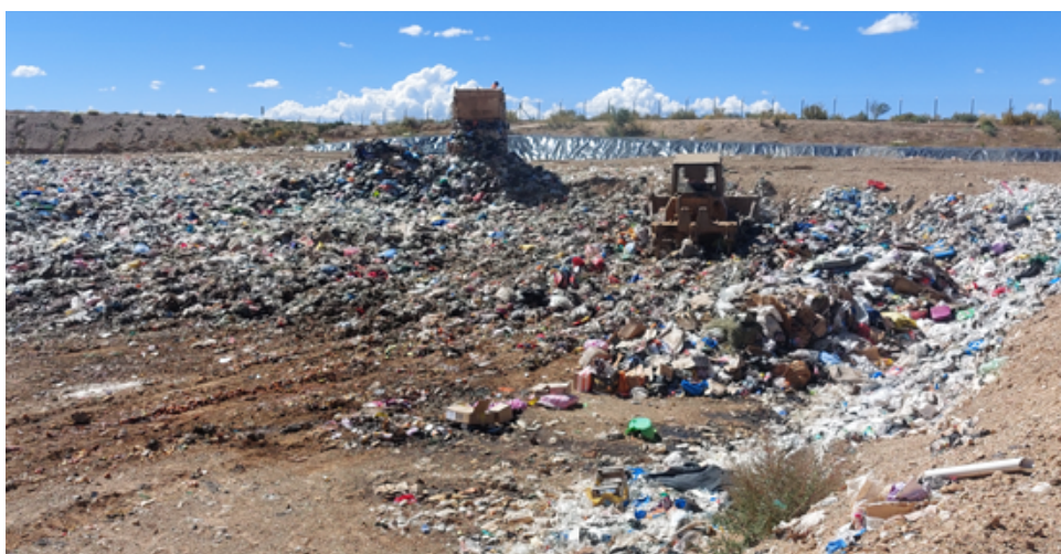
Figura 46. Distribución y conformación de residuos en celda.
