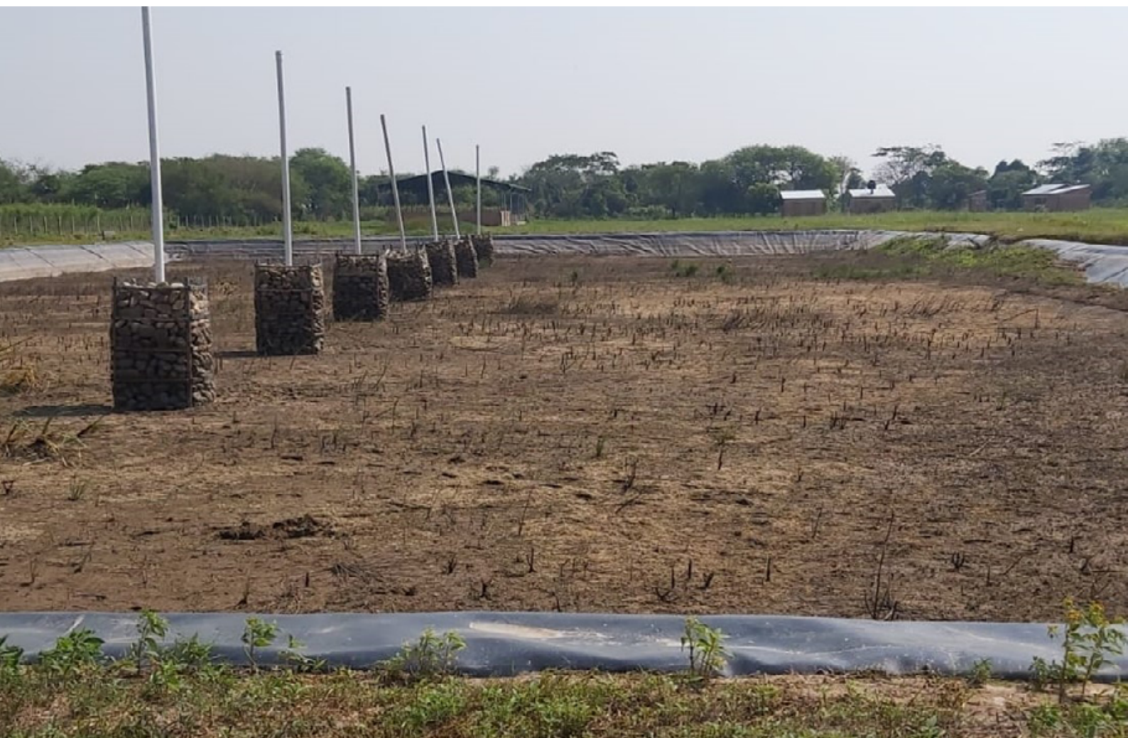
Macrocela Relleno Sanitario Semimecanizado, Okinawa, Santa Cruz
