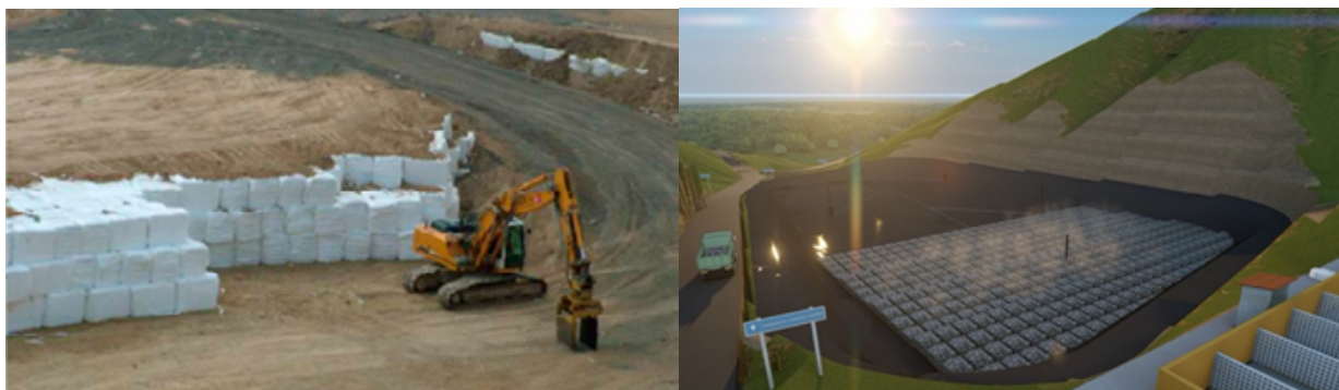
Figura 30. Relleno sanitario semi-seco
