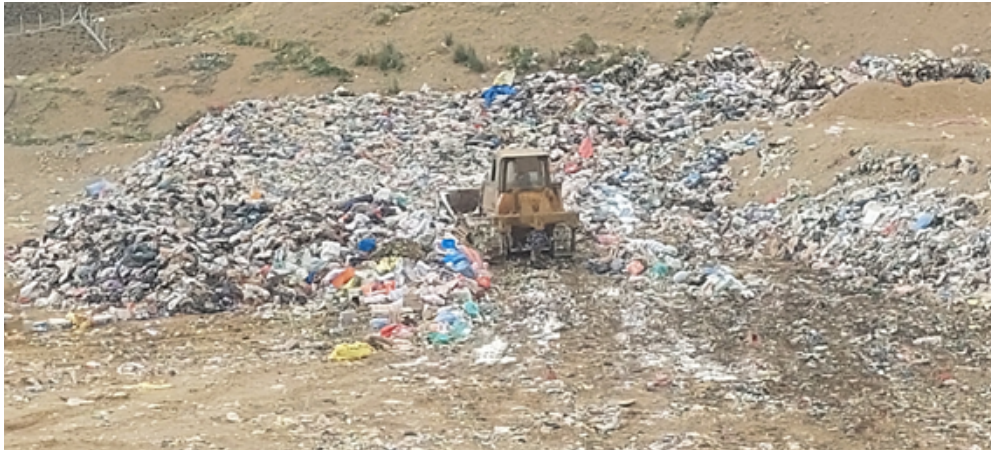
Figura 47. Compactación de Residuos.
