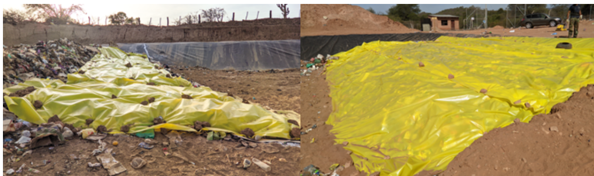
Figura 49. Tendido de Geo Sintéticos en Celda Diaria.
