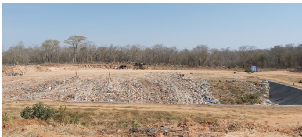
Figura 50. Cobertura Final de la Celda.
